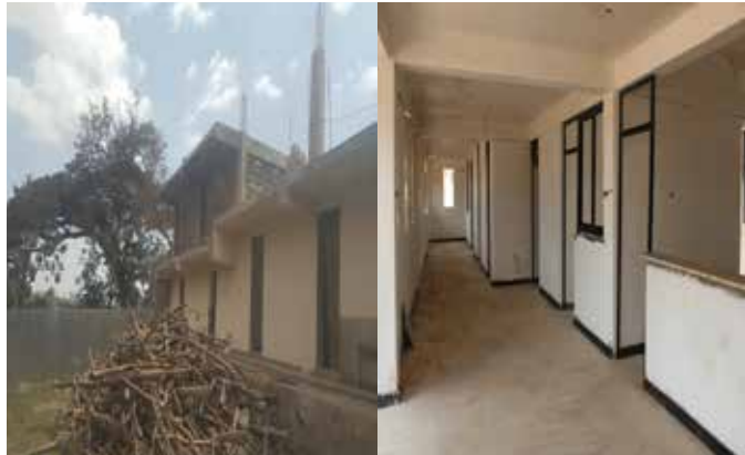
የግንባታ ካይ ያክ የሆሳዕና አረጋዊያን ማዕከል እና የመንግስት ባክሰኩላትናት የማዕከሉ ጉብኝት
